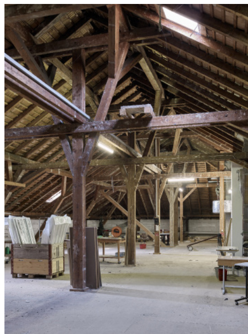
Der Dachstuhl vor dem Umbau.
