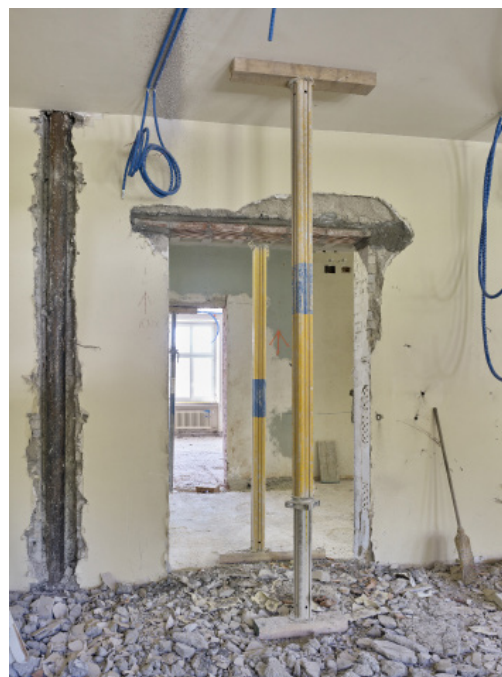
Neuer Durchblick dank der Bauarbeiten.
