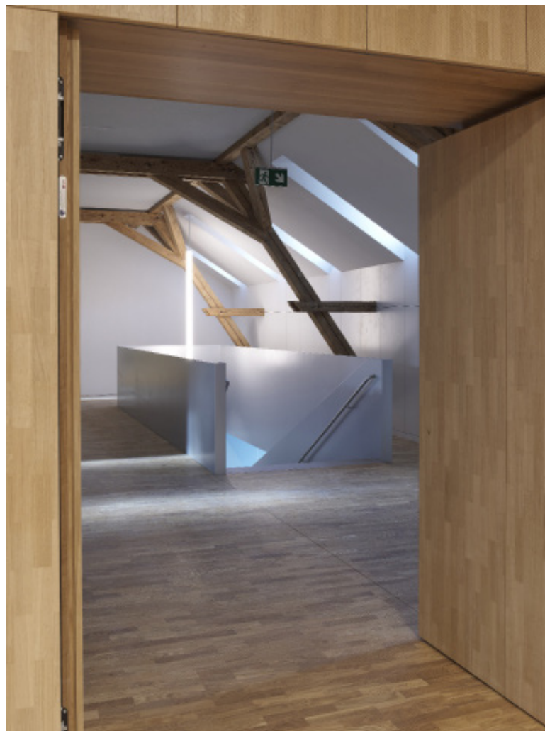
Eine Stahltreppe führt ins neu ausgebaute Dachgeschoss.
