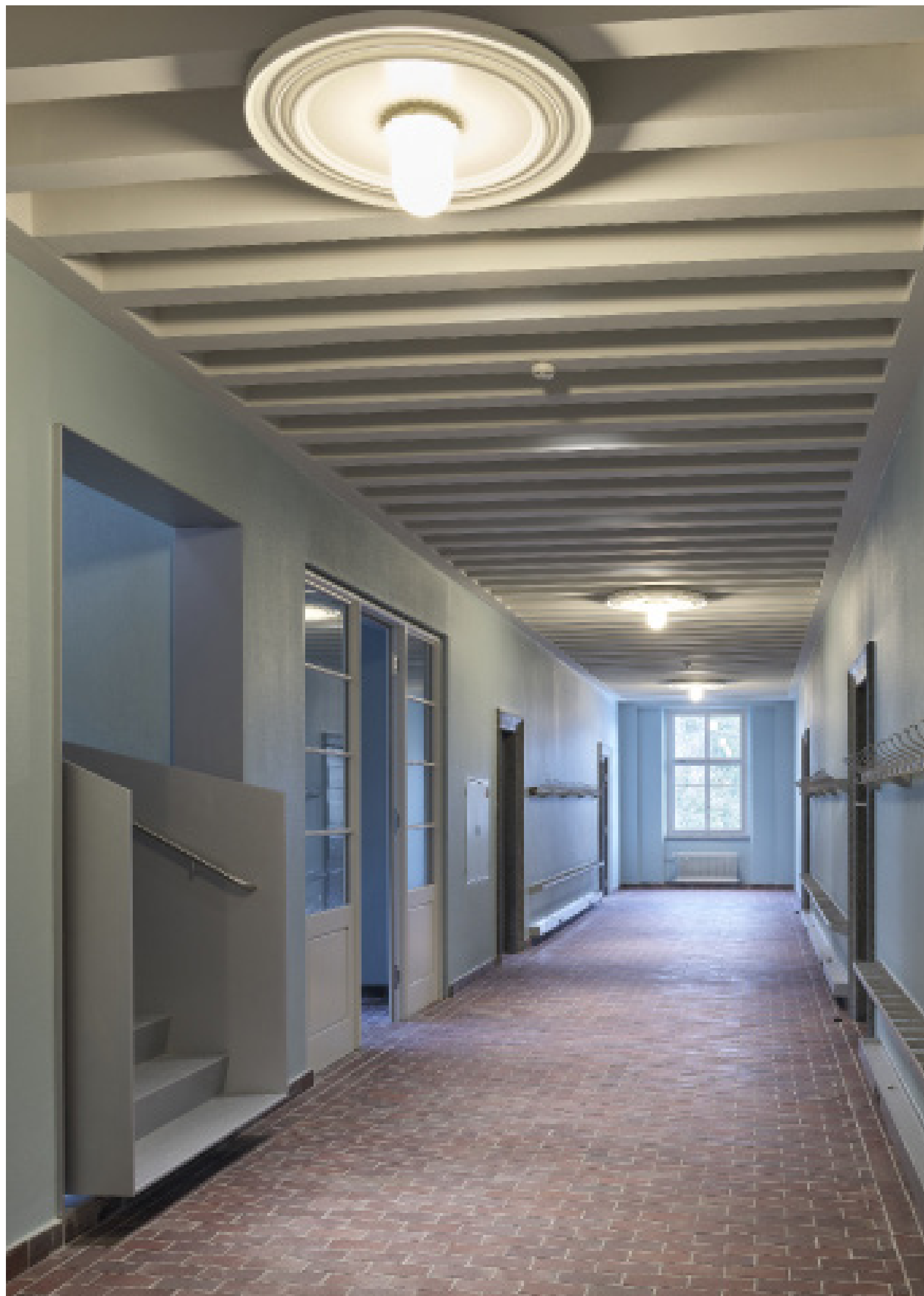
2. Obergeschoss: Die Hallen und Korridore haben ihre ursprüngliche Farbfassung zurückerhalten. Die neue Treppe zum Dachgeschoss setzt sich vom Altbau ab.
